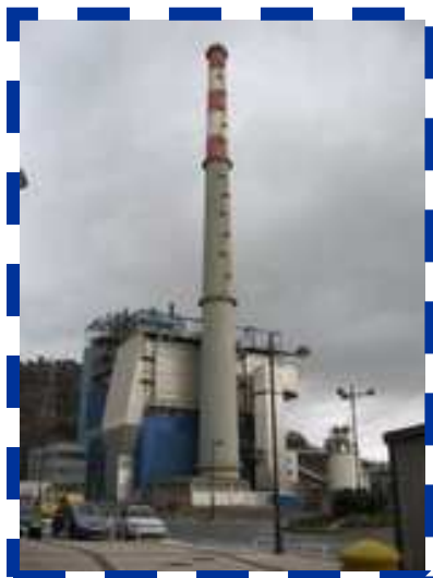
FOTO 10. La central térmica.
