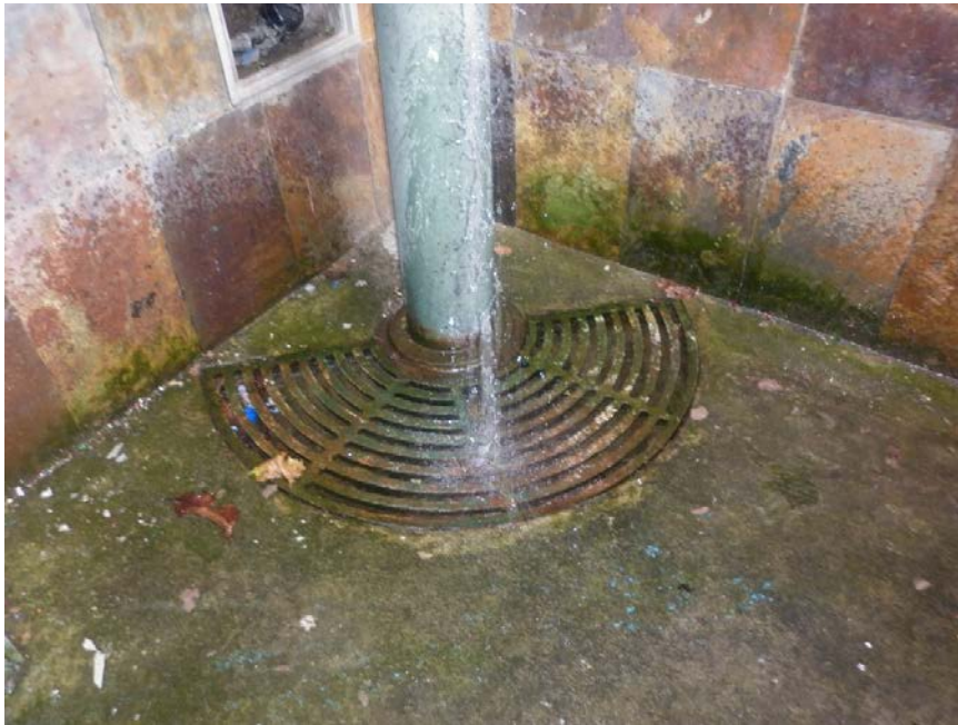
Foto 57. Fuente 11S. Desagüe.
