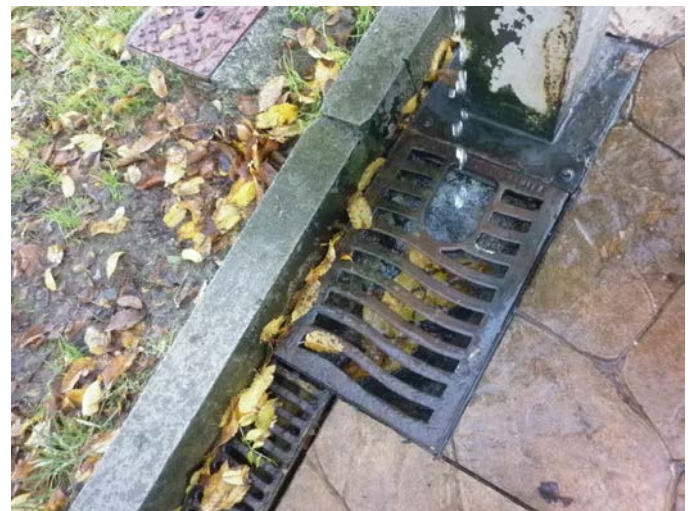
Foto 24. Fuente 2T. Detalle del desagüe.
