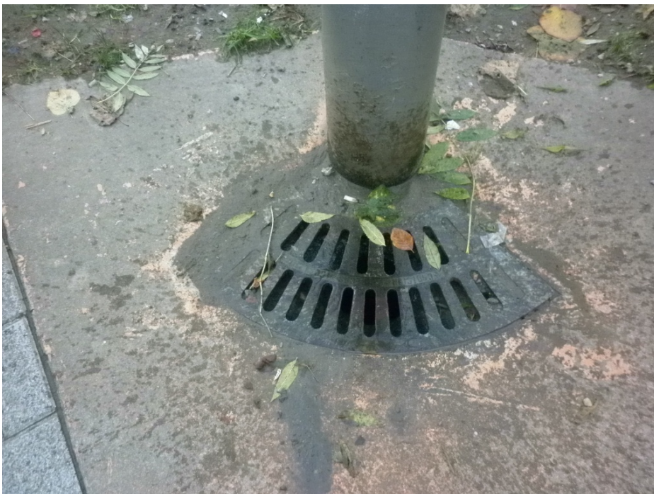
Foto 27. Fuente 3T. Detalle del desagüe de la fuente.
