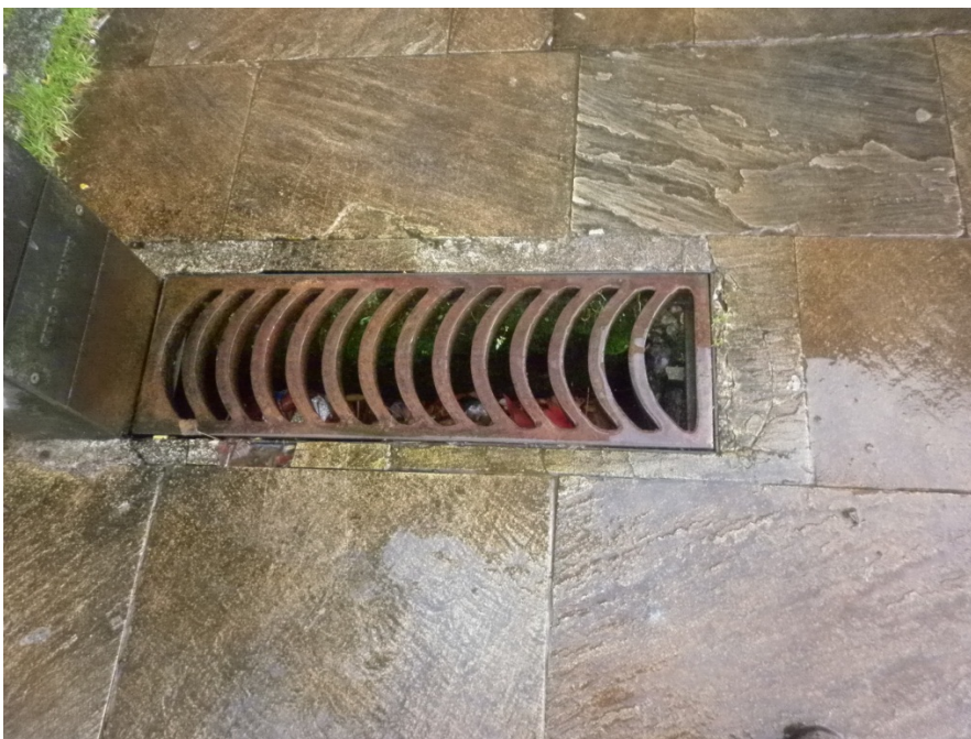
Foto 42. Fuente 4S. Desagüe de la fuente.
