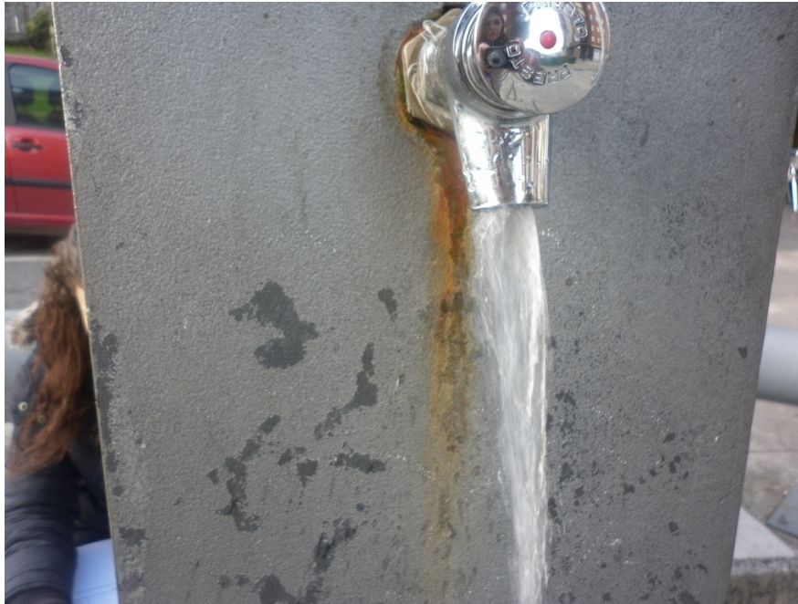
Fuente 52. Fuente 9S. Grifo y fuente en funcionamiento.
