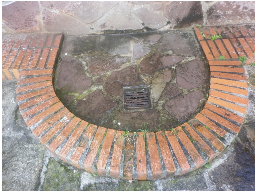
Foto 55. Fuente 10S. Desagüe y borde de la fuente.
