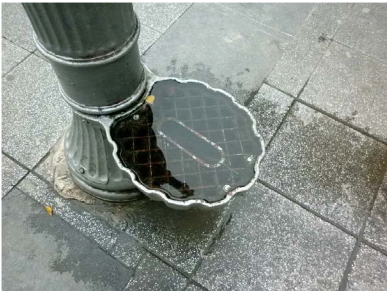
Foto 16. Fuente 3A. Desagüe de la fuente.
