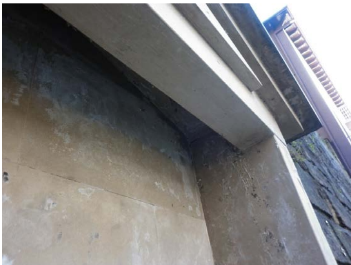
Foto 40. Fuente 3S. Suciedad en la parte superior de la fuente.
