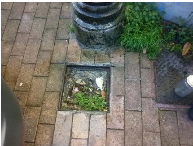
Foto 34. Fuente 1S. Desagüe inadecuado
