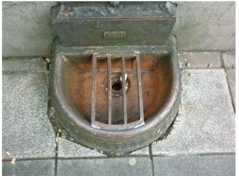
Foto 18. Fuente 4A. Desagüe de la fuente.
