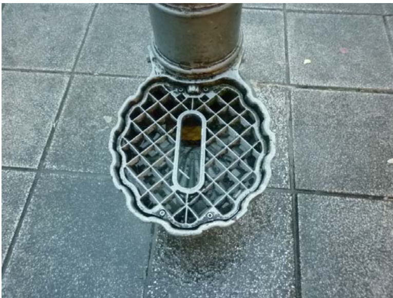
Foto 20. Fuente 5A. Desagüe de la fuente.
