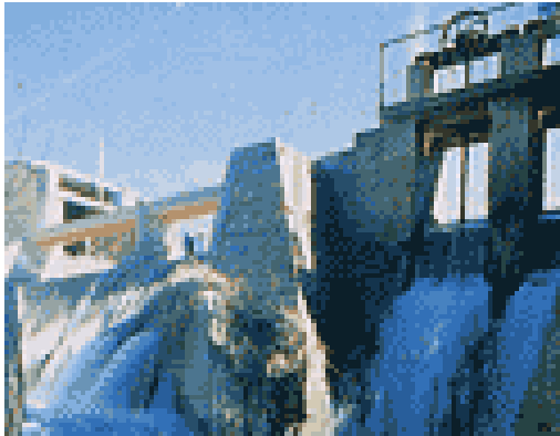
FOTO 4. Instalaciones de una central hidráulica.
