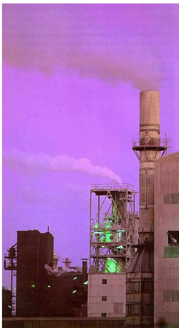
FOTO 11. Imagen de una central térmica.
