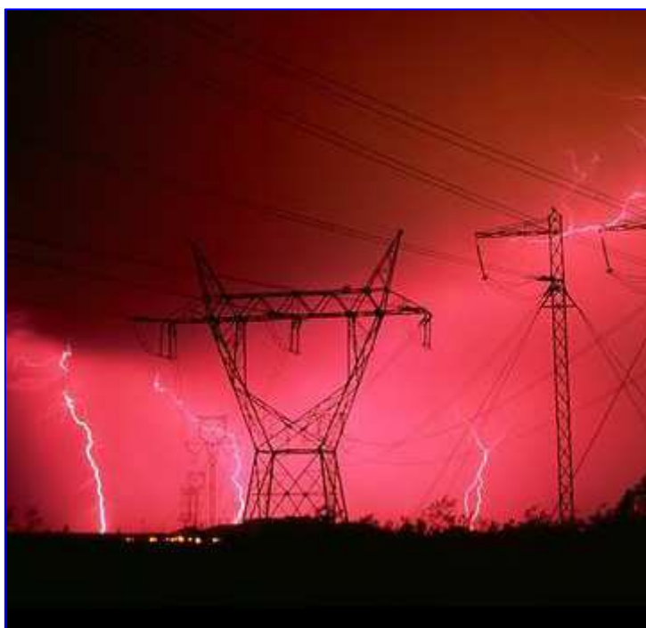
FOTO 12. Líneas de alta tensión.
