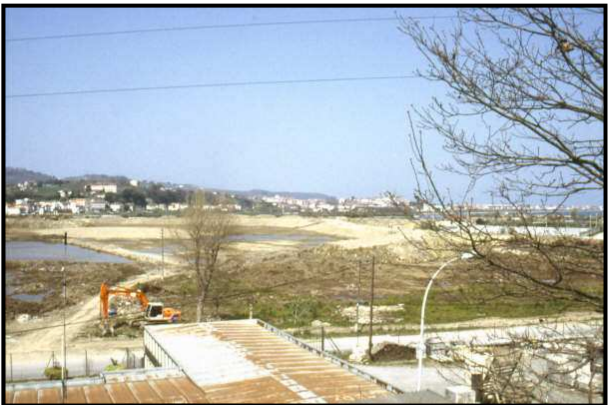
Foto 5. Vista del futuro parque en obras iniciales. Detalle de una excavadora.
