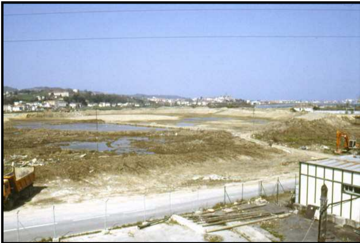
Foto 6. Vista general del parque previa a su construcción.
