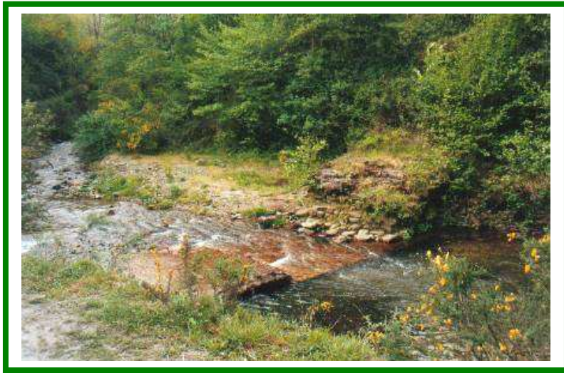
FOTO 8. Restos de la presa en la unidad 3 .
