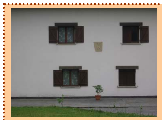
FOTO 20. Caserío Galantene, detalle de la fachada, en el punto de muestreo 2 .
