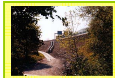
FOTO 9. Autopista A-8 a su paso por el punto 1 .
