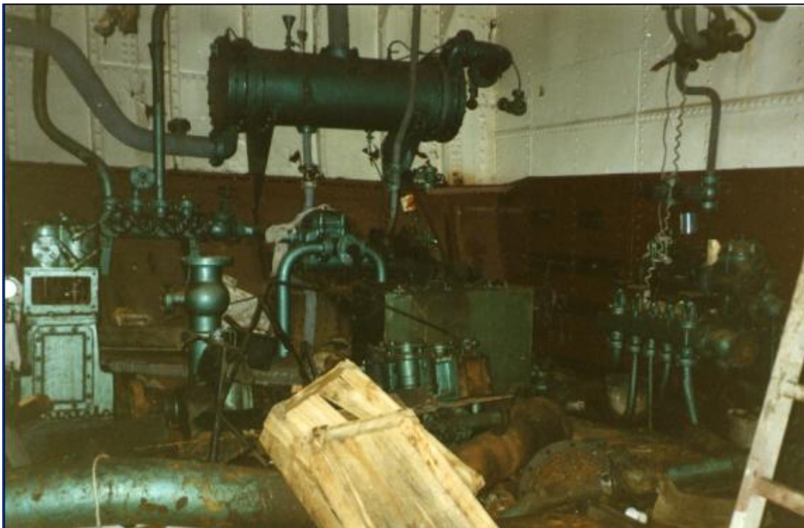
FOTO 16. DRAGA JAIZKIBEL, sala de máquinas.
