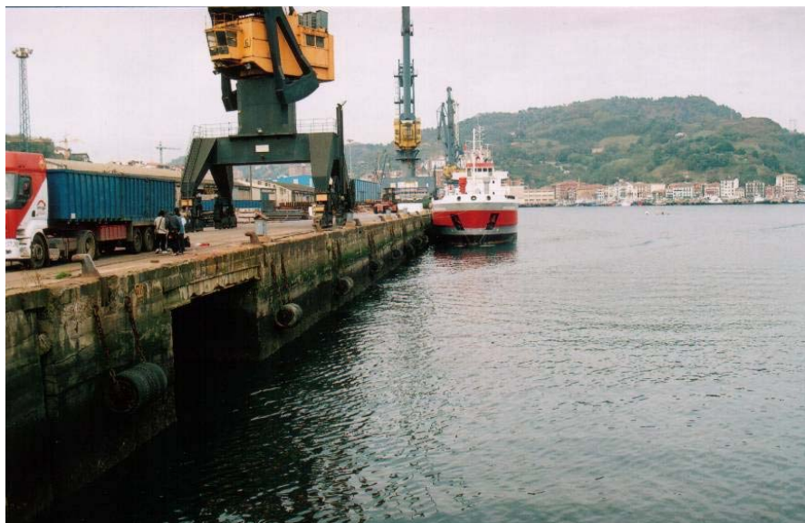
FOTO 40. Área 10, con presencia de manchas de aceite en el agua.
