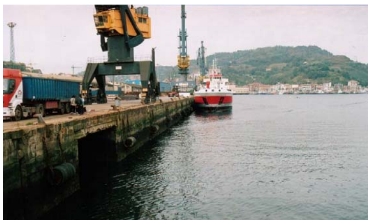
FOTO 31. Cobertura de otras construcciones (muelles) en mesolitoral, debido al puerto.
