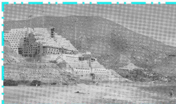
FOTO 17. Hotel que será derribado en el litoral andaluz.
