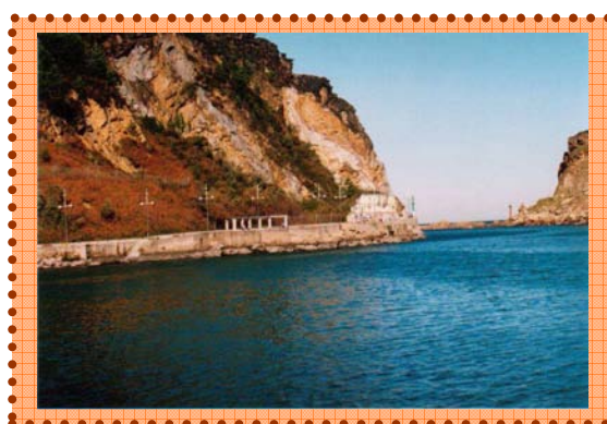
FOTO 24. Zona de Puntxas, con riesgo por la erosión y la Bocana del Puerto de Pasaia.
