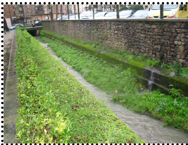
FOTO 70. Canalizaciones del punto 2.
