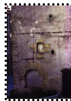
FOTO 51. Casa de la calle San Juan Nº 2.
