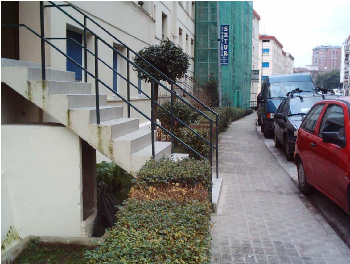
FOTO 1. Jardín 53. Vista general de la zona. Al fondo el andamio de obras.
