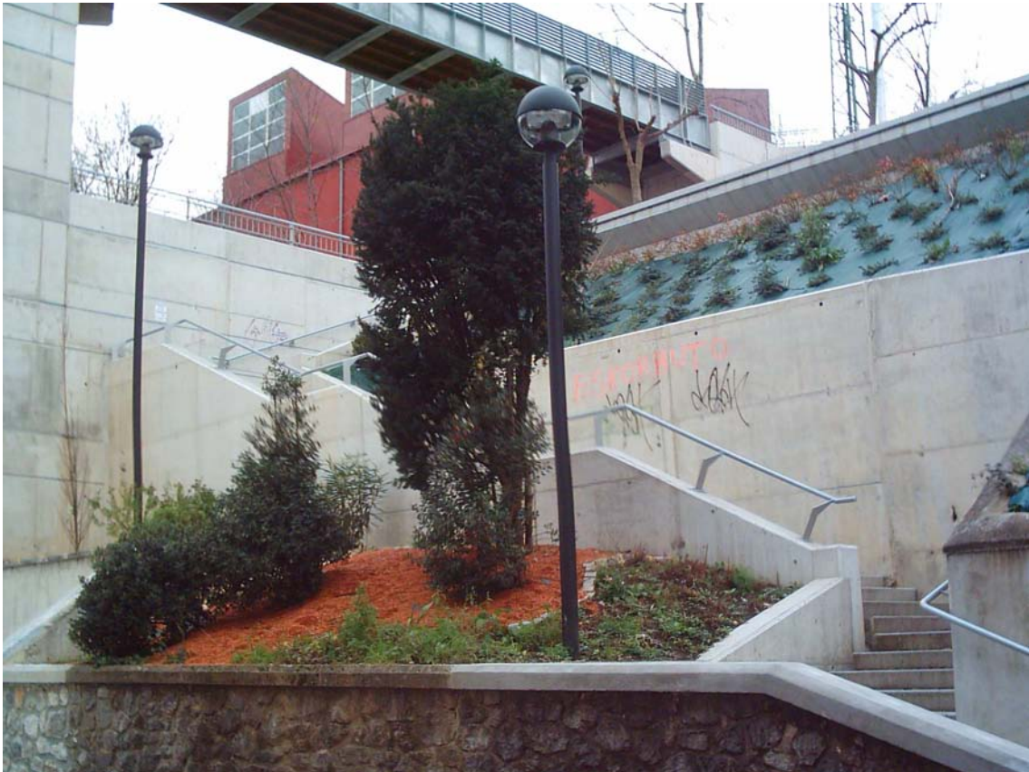
FOTO 1. Jardín 28. Vista general de la zona junto a las escaleras, se aprecia el muro de contención y el barandado.
