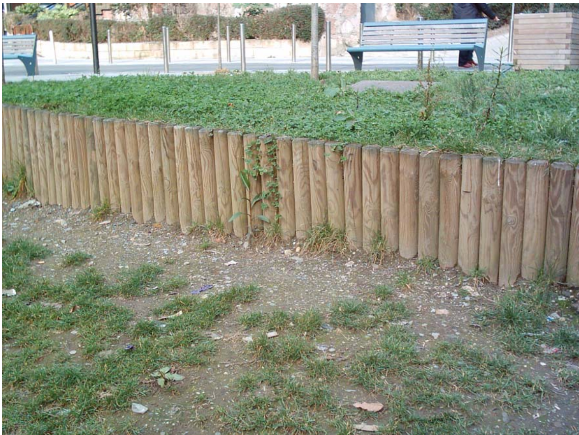
FOTO 4. Jardín 2. Detalle de uno de los escalones de contención
