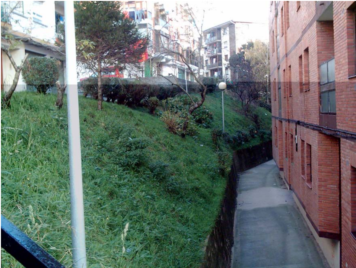
FOTO 1. Jardín 18. Vista general de la zona y el muro de contención junto a las viviendas.
