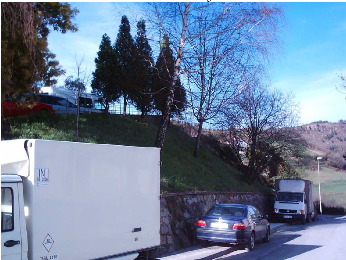
FOTO2. Jardín 17. Vista general del muro de contencion.
