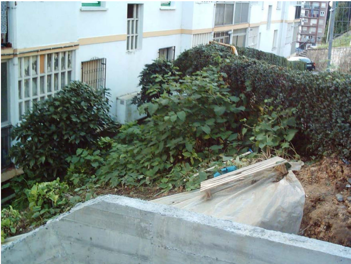
FOTO 1. Jardín 20. Detalle de la basura de la zona y el muro de futuras escaleras mecánicas.
