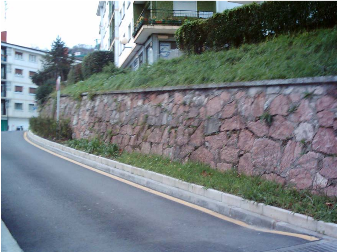
FOTO 2. Jardín 23. Detalle del muro de contención y cierre natural en la zona superior.
