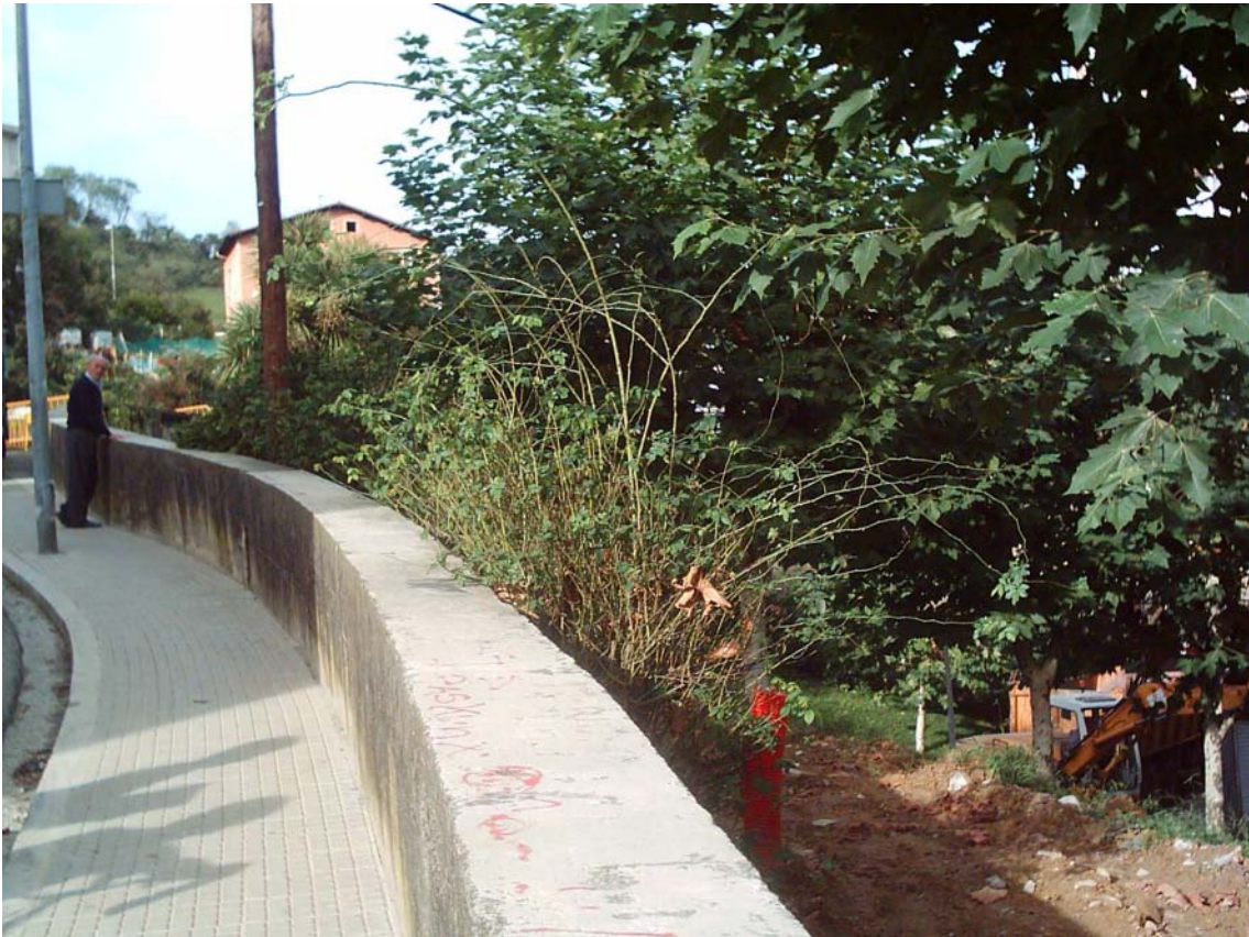
FOTO 1. Jardín 7. Detalle del cercado del jardín y de las obras.
