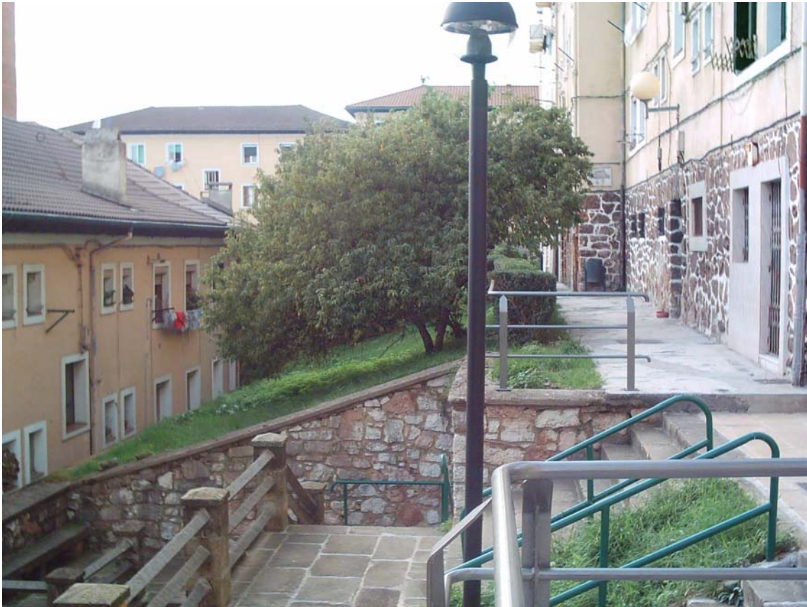
FOTO 1. Jardín 4. Vista general de una de las áreas y de las escaleras que dividen
