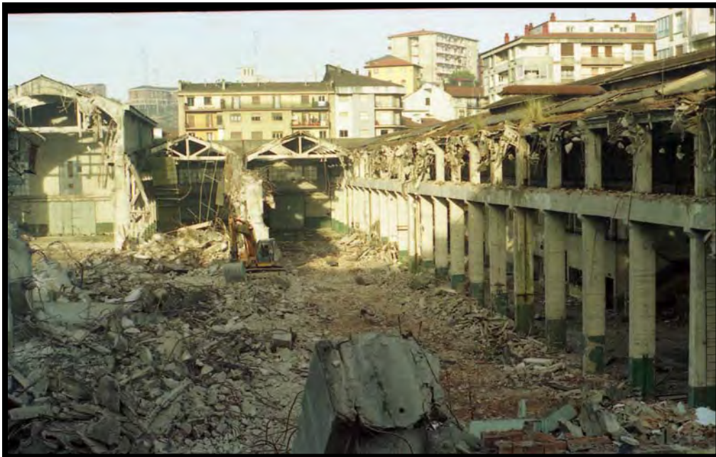
Derribo del interior del taller mecánico
