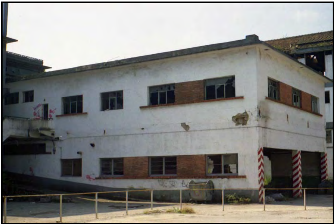
Edificio de la Escuela
