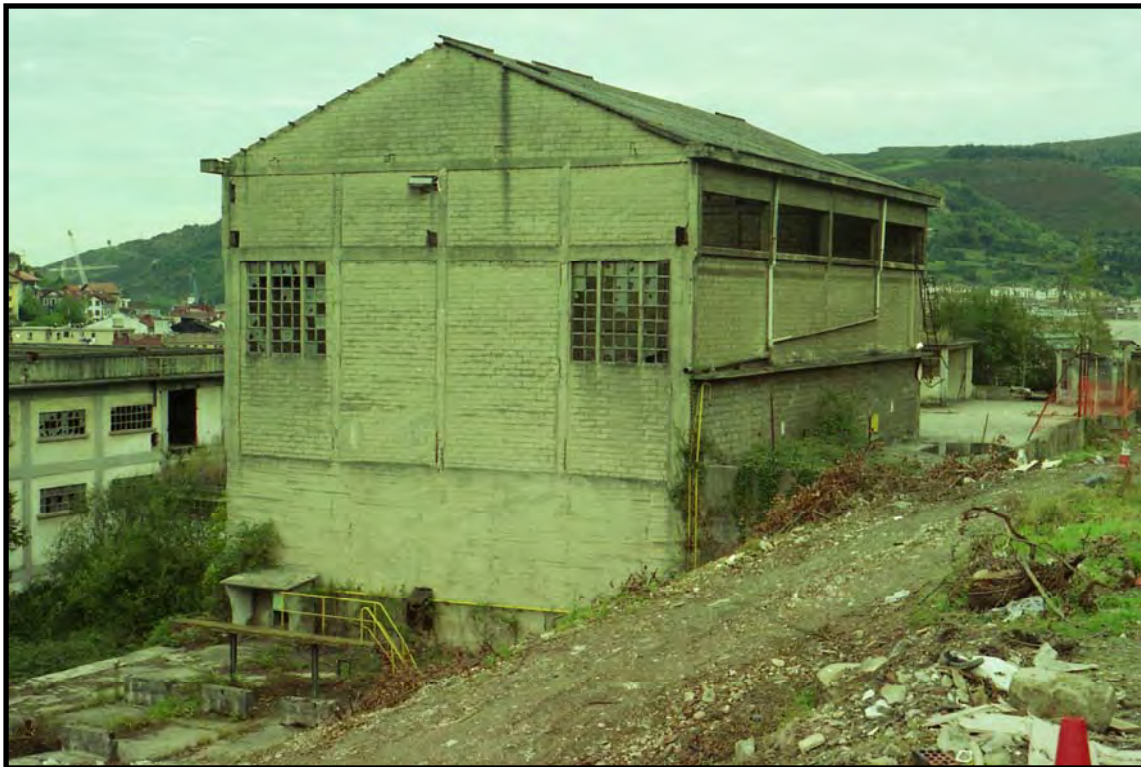
Instalaciones del edificio de arenas de machería
