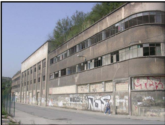
Fachada de las oficinas, Septiembre 2008.
