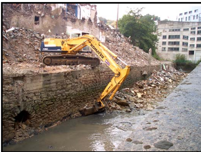
Escombros de antiguas fábricas en la Ría
