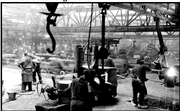
Obreros con boinas y sin guantes en la Fundición.
