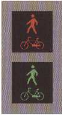
FOTO 6. Semáforo combinado para peatones y ciclistas.
