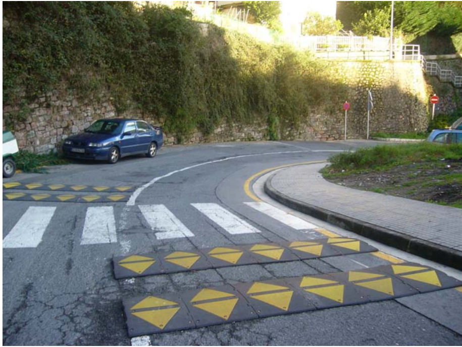
FOTO 3. Zona que necesita una acera por el lado izquierdo.
