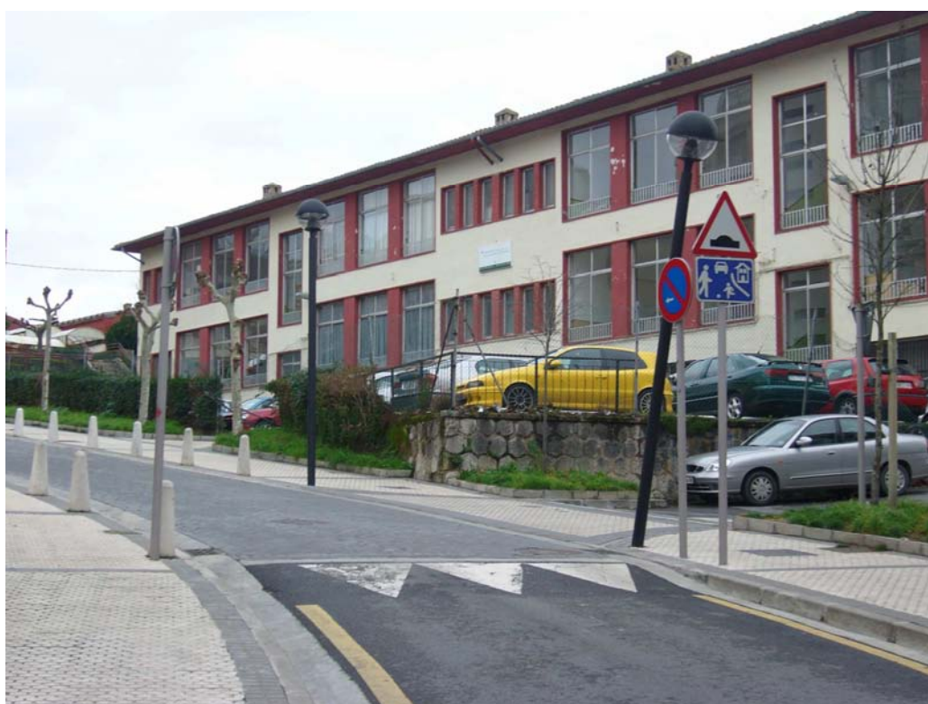
FOTO 2. Entrada al Colegio Virgen del Carmen, zona remodelada.
