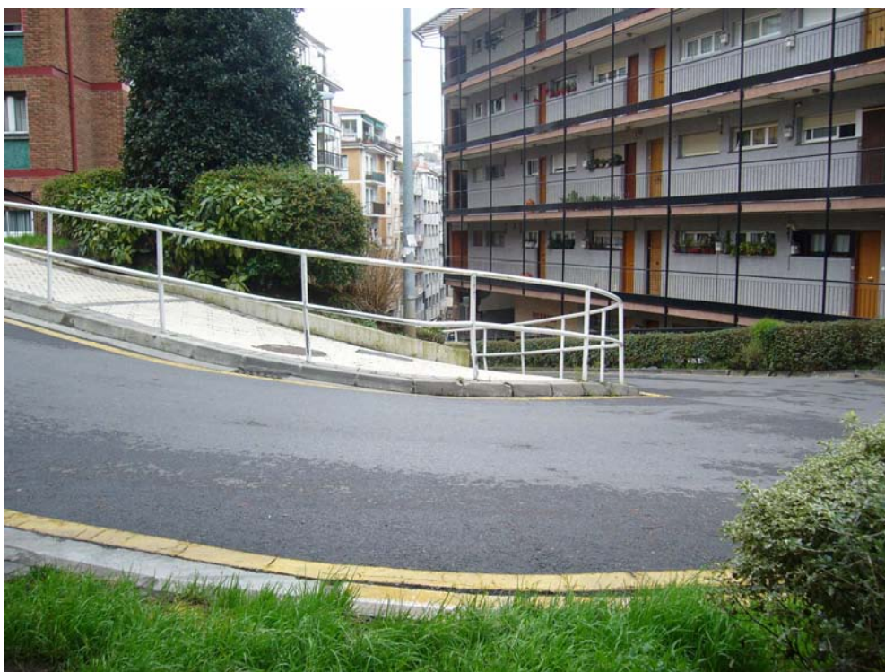
FOTO 1. Inicio del tramo, junto a la C/ Jaizkibel.
