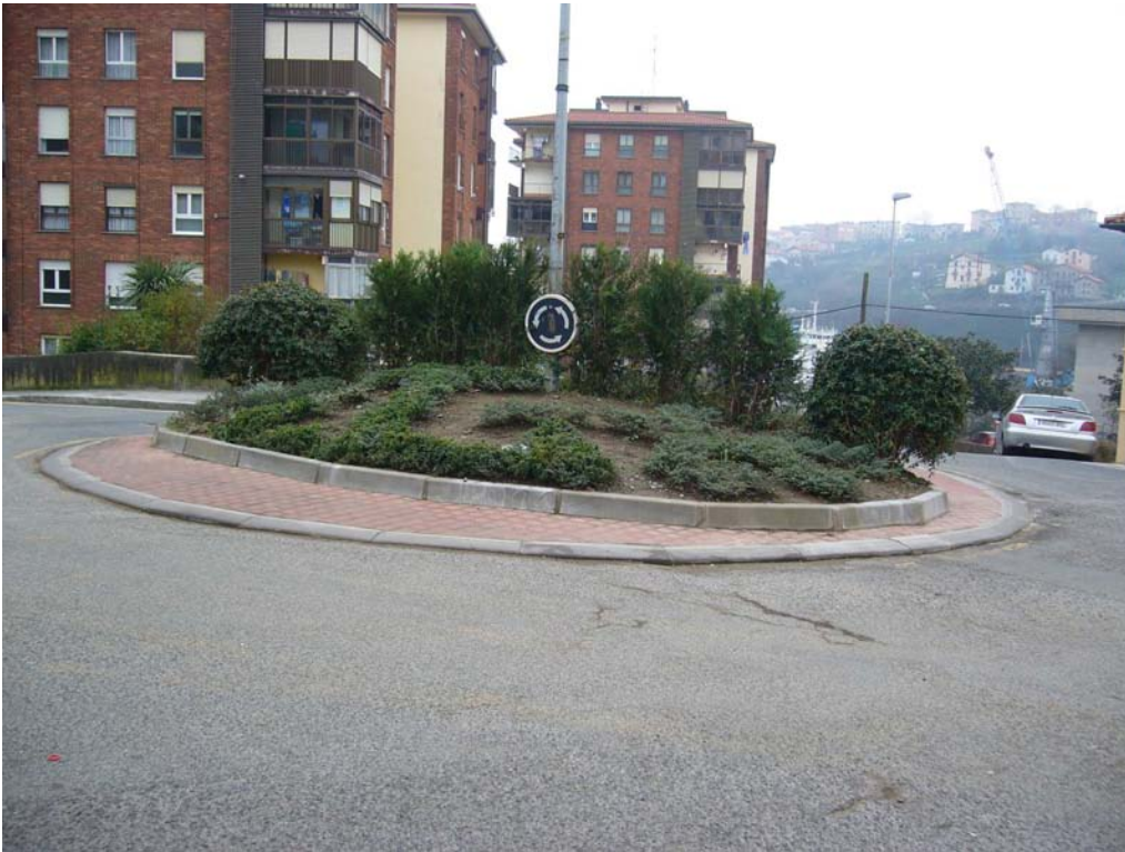
FOTO 1. Rotonda totalmente renovada.
