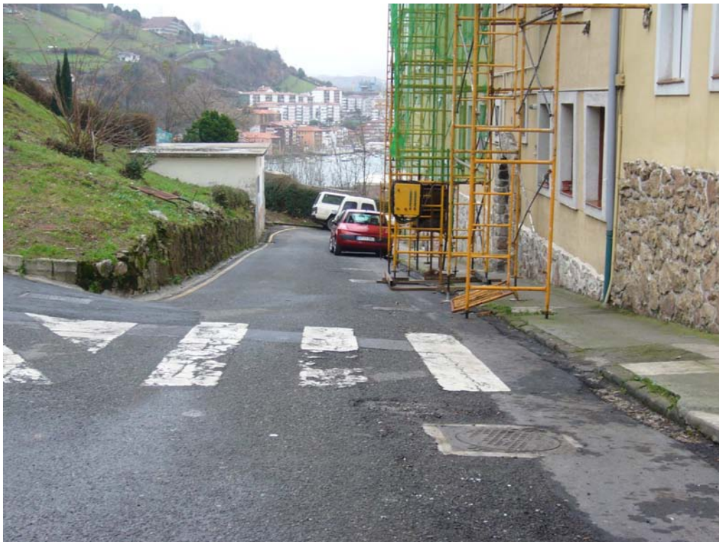
FOTO 2. Paso de cebra que debe incluir un paso de cebra de ciclistas. Andamio de obras en el lado derecho.
