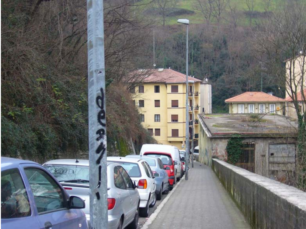
FOTO 1. Farolas elevadas y muro de hormigón.
