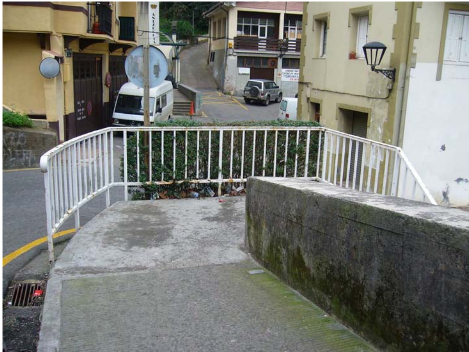
FOTO 2. Parte final del tramo. En las escaleras se colocan carriles – rampa para bicicletas.
