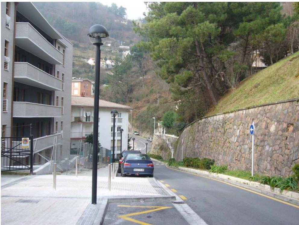
FOTO 4. Buena iluminación, toda la calle renovada.
