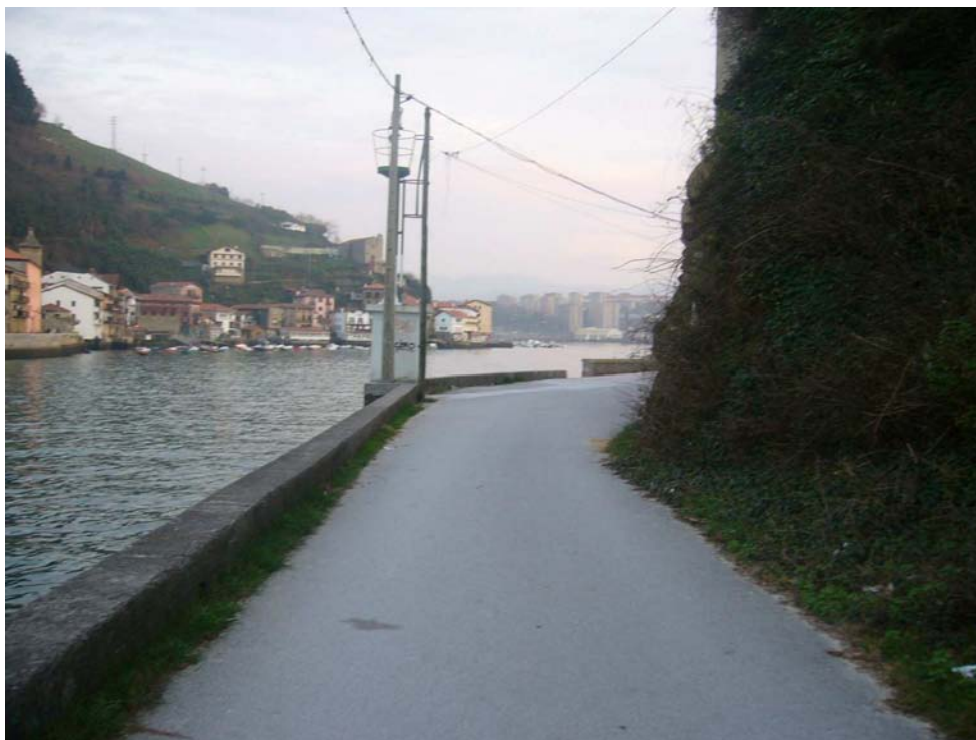
FOTO 3. Detalle del muro de hormigón que se debería reparar y levantar más.
