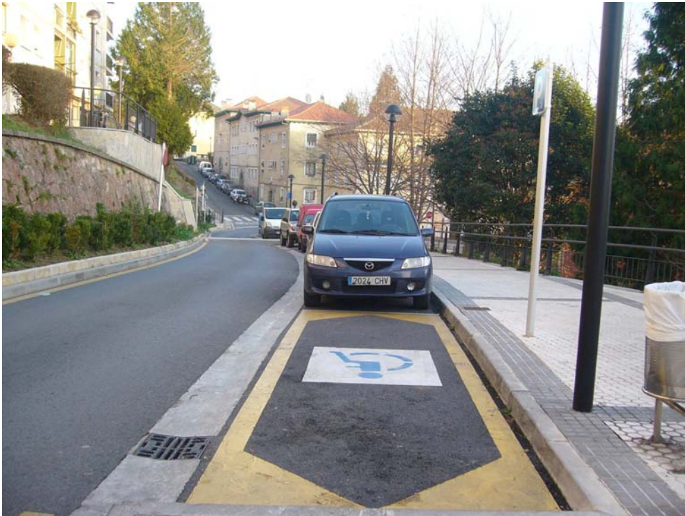
FOTO 3. Señales de tráfico que se deben mover. Acera de la izquierda inexistente.
