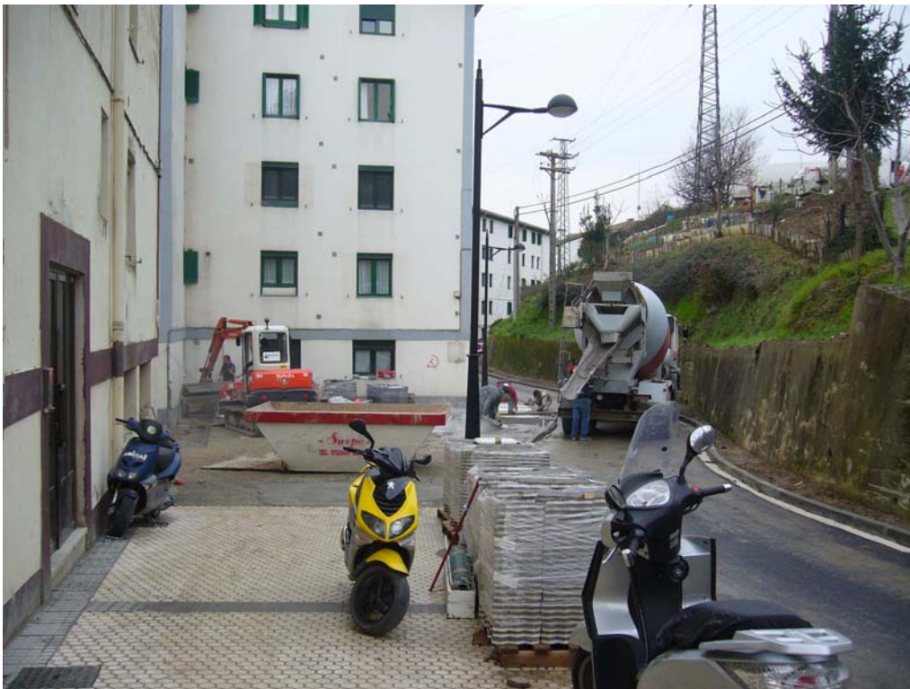
FOTO 2. Zona de la calle en obras.
