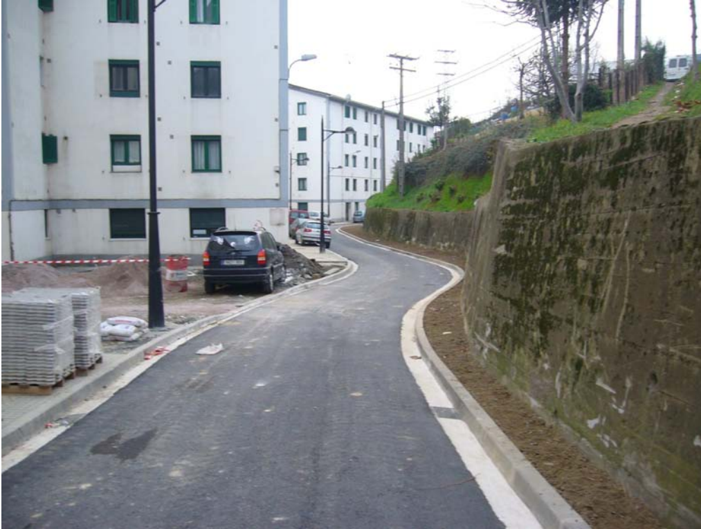
FOTO 5. Tramo en obras.
