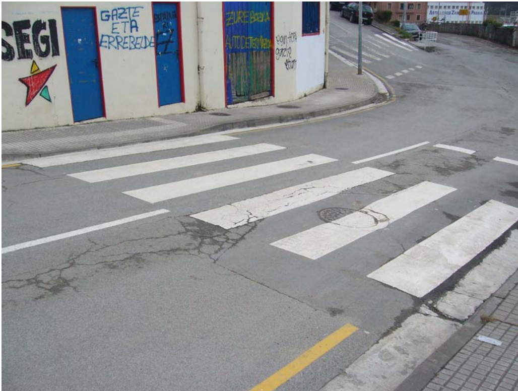
FOTO 1. Final del tramo con paso de ceбра. Colocar paso de ceбра de ciclista.
