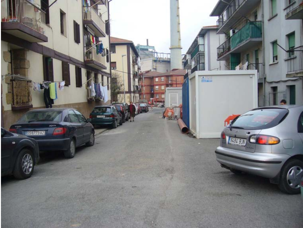
FOTO 3. Casetas de obras ocupando aparcamiento y coches encima de la acera.
