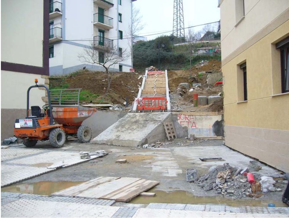
FOTO 1. Obras del ascensor y escaleras mecánicas.
