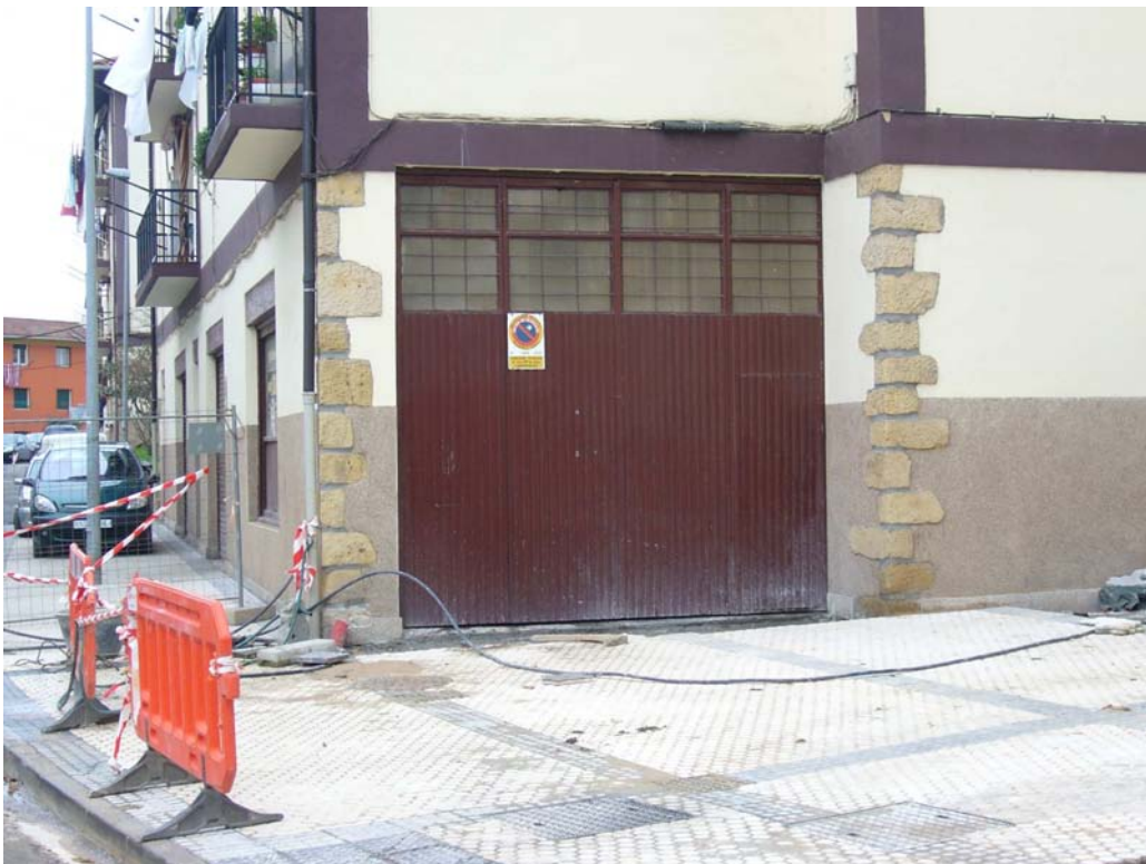
FOTO 2. Acera en obras. Farolas en el centro de la calle que se deben desplazar.
