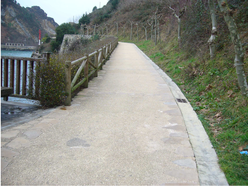
FOTO 1. Tramo totalmente remozado. Vallado de madera al lado del acantilado.
