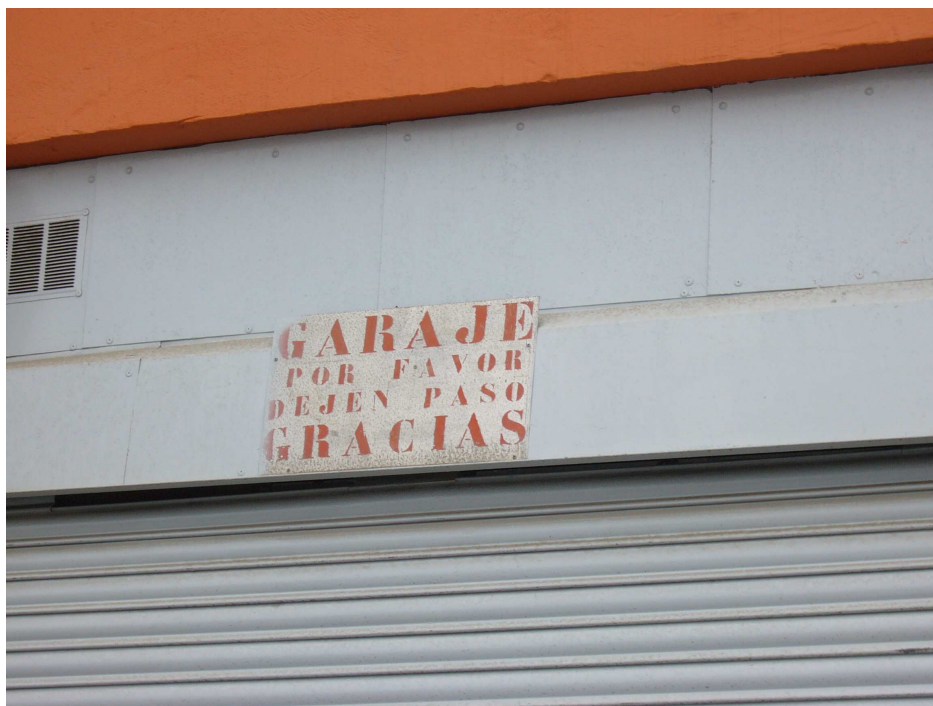
FOTO 3. Zona de garajes.
