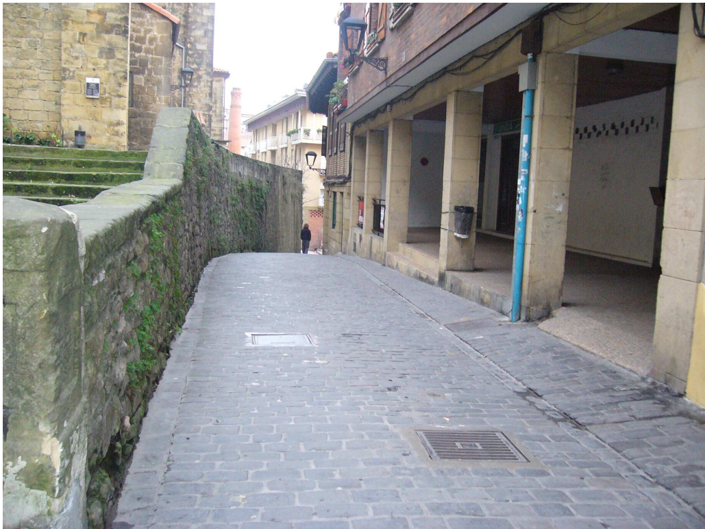
FOTO 2. Adoquines en la calzada.
