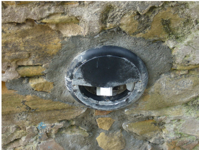
FOTO 2. Detalle de iluminación en mal estado.
