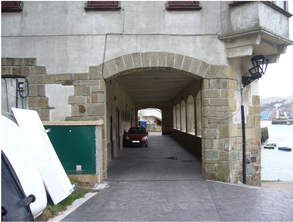
FOTO 3. Fin del tramo. A la derecha rampa de acceso al mar.
