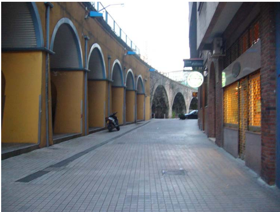
FOTO 2. Alcantarillado en la zona más ancha del tramo 1.1.
