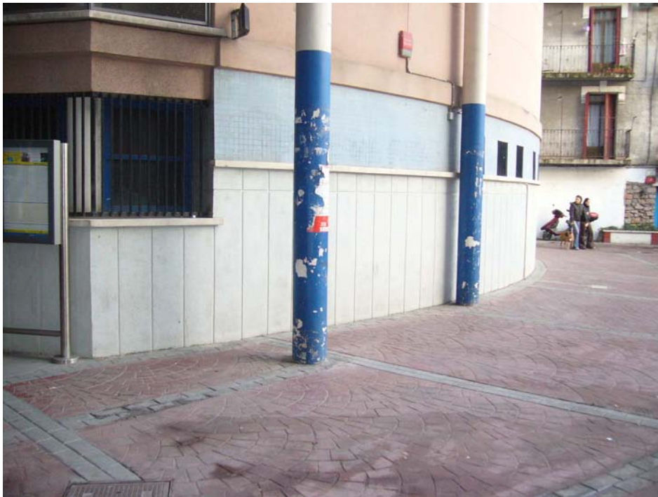
FOTO 4. Entrada a la estación del TOPO, zona apropiada para instalar un aparcabicis.
