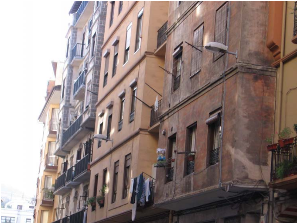
FOTO 4. Farolas en la fachada de la casa.
