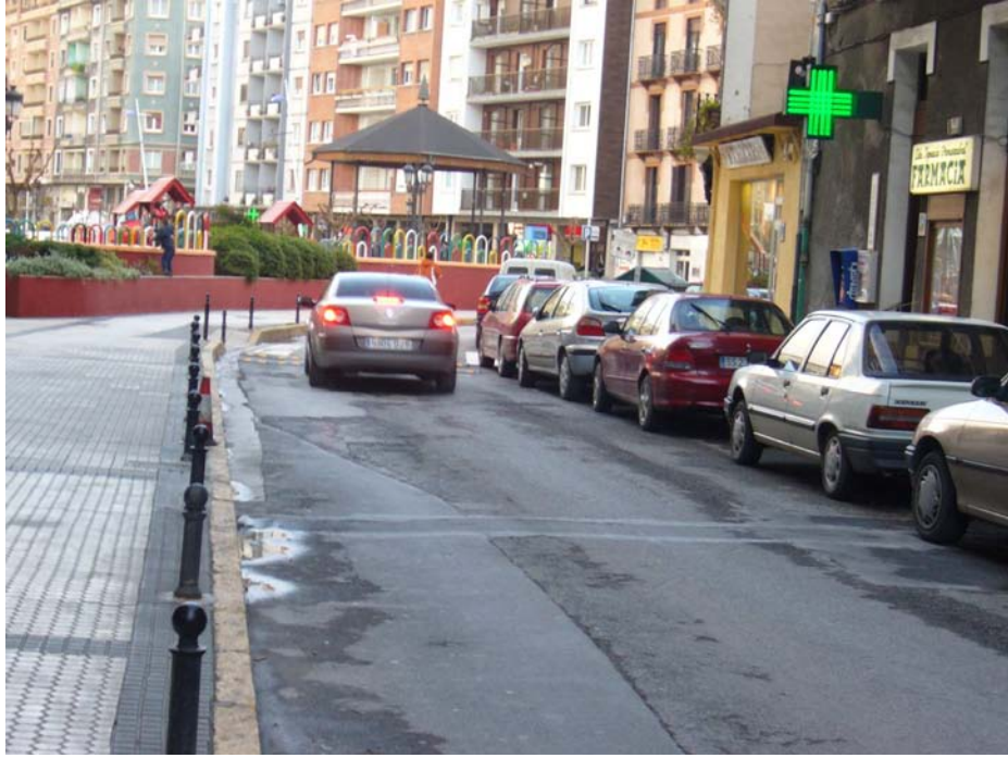
FOTO 1. C/ Eskalantegi, zona de aparcamientos de coches que se debe reducir.
