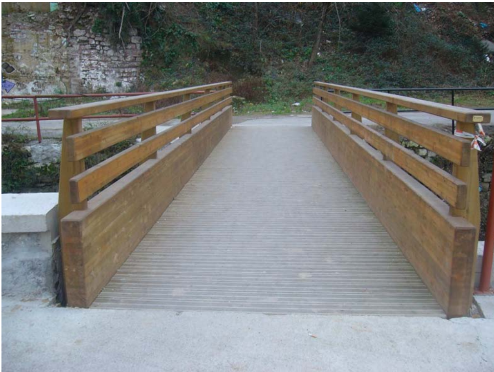
FOTO 2. Puente al final del tramo para enlazar con el tramo 6.
