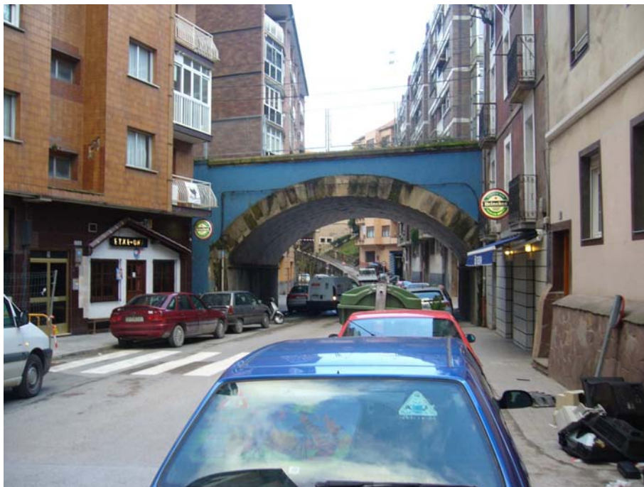
FOTO 4. C/ Eskalantegi, el lado derecho tiene prohibido el aparcamiento.
