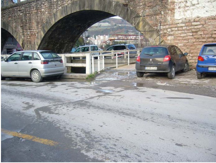
FOTO 3. Cruce con la C/ Carretera de San Marcos.
