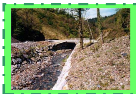
FOTO 45. Pequeña canalización con escollera, punto 1 .
