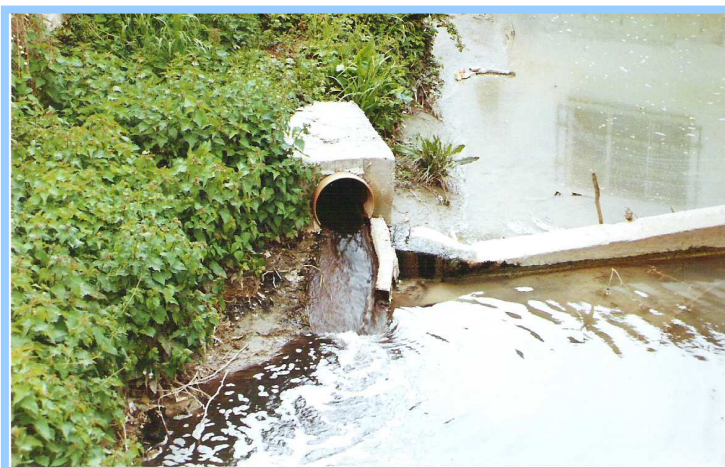
FOTO 34. Interceptor de los lixiviados del vertedero R.S.U. de San Marcos que se vertieron en el pasado en el punto 3 hasta finales del 2005
