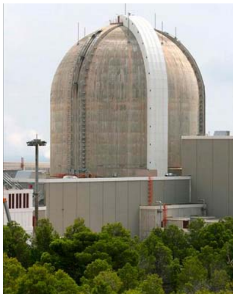
FOTO 17. Central nuclear de Vandellós II.
