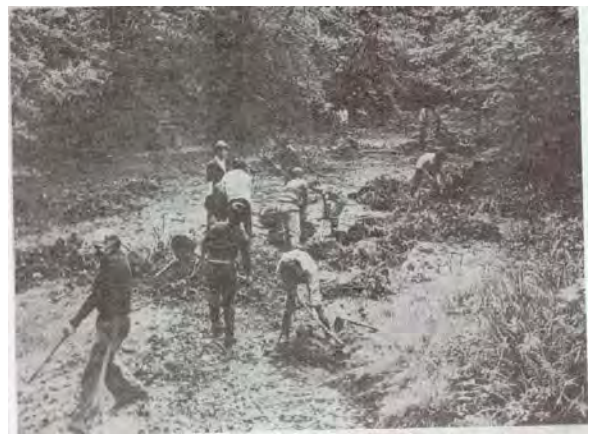
FOTO 4 Reforma del Parque.
