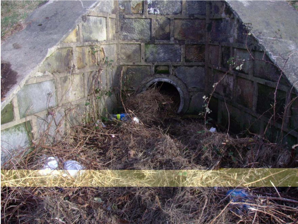
FOTO 7. Basura y acumulación de hierba encontrada en la regata numero 5.
