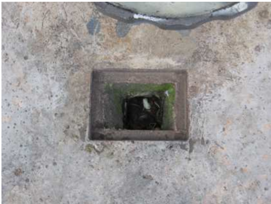
FOTO 3. Fuente 5. Desagüe secundario de la fuente. Considerado peligroso por no tener ninguna protección.
