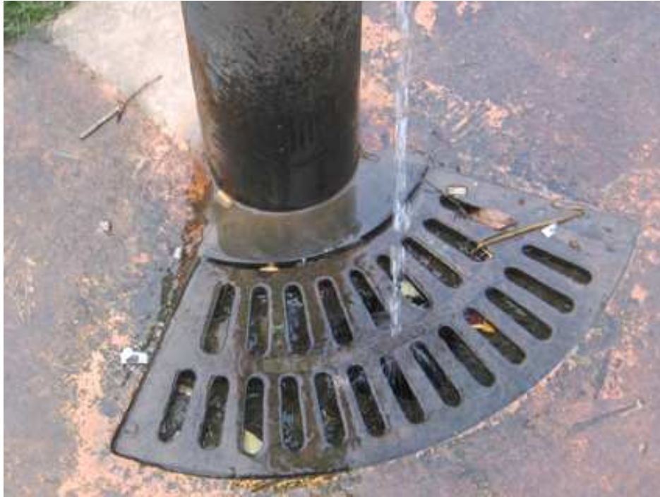
FOTO 2. Fuente 3. Desagüe de la fuente cuando esta está en funcionamiento. Se aprecia donde golpea el agua y como consecuencia sale fuera.
