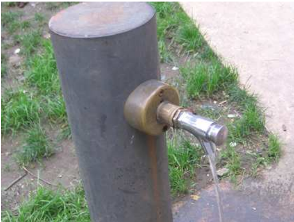
FOTO 3. Fuente 3. El grifo en funcionamiento.
