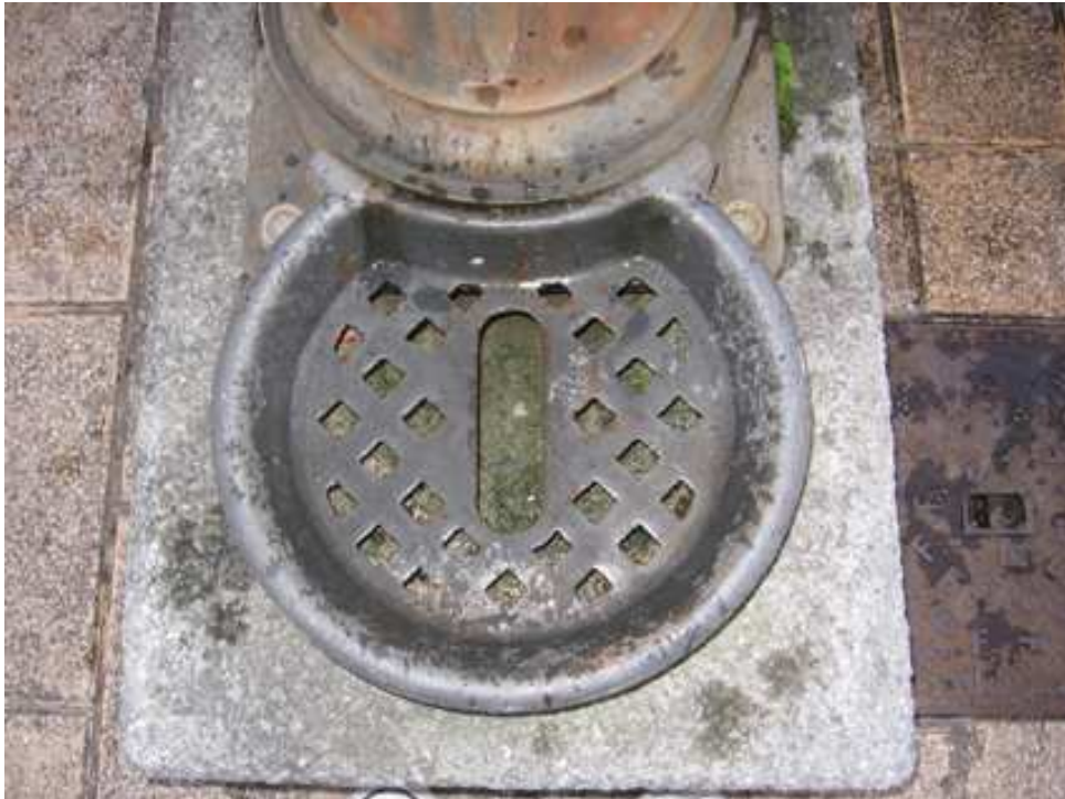
FOTO 3. Fuente 9. Uno de los desagües de la fuente.
