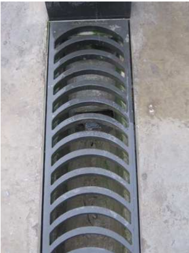
FOTO 3. Fuente 5. El desagüe de la fuente.
