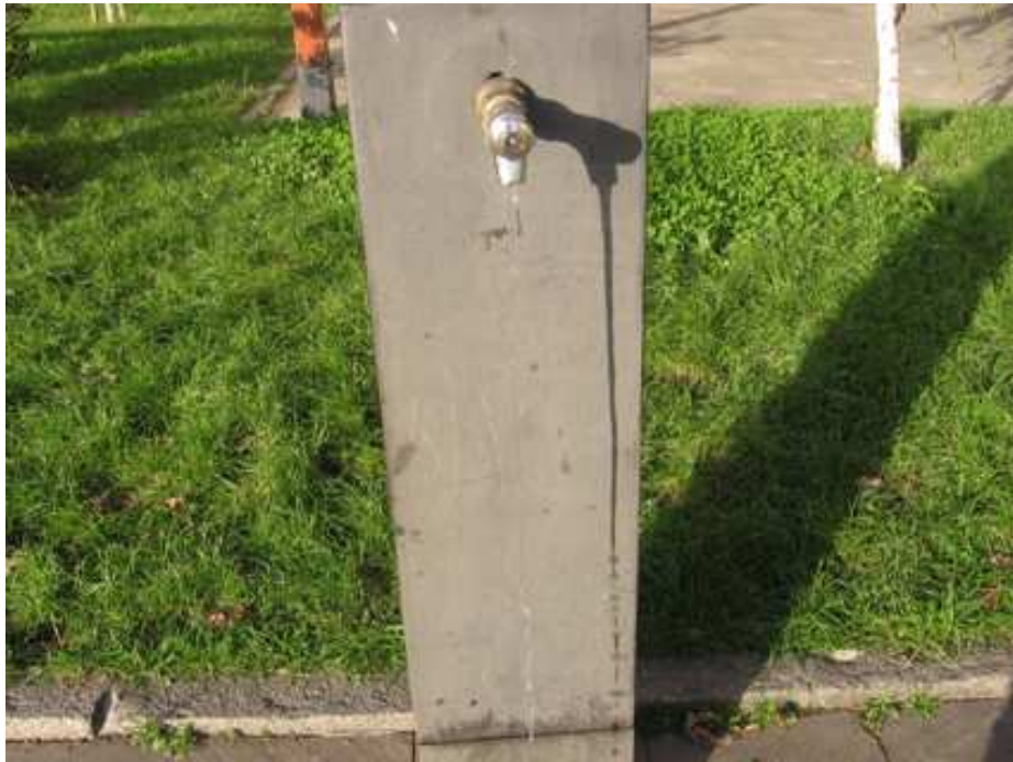
FOTO 2. Fuente 6. El grifo en funcionamiento.
