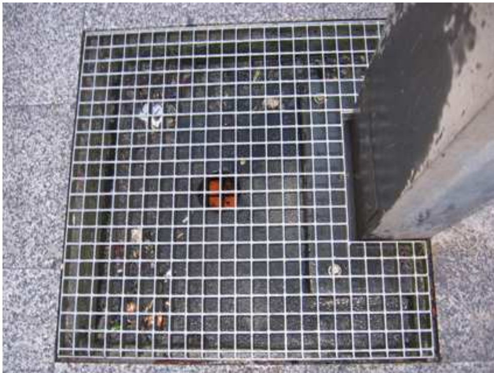
FOTO 3. Fuente 7. El desagüe.
