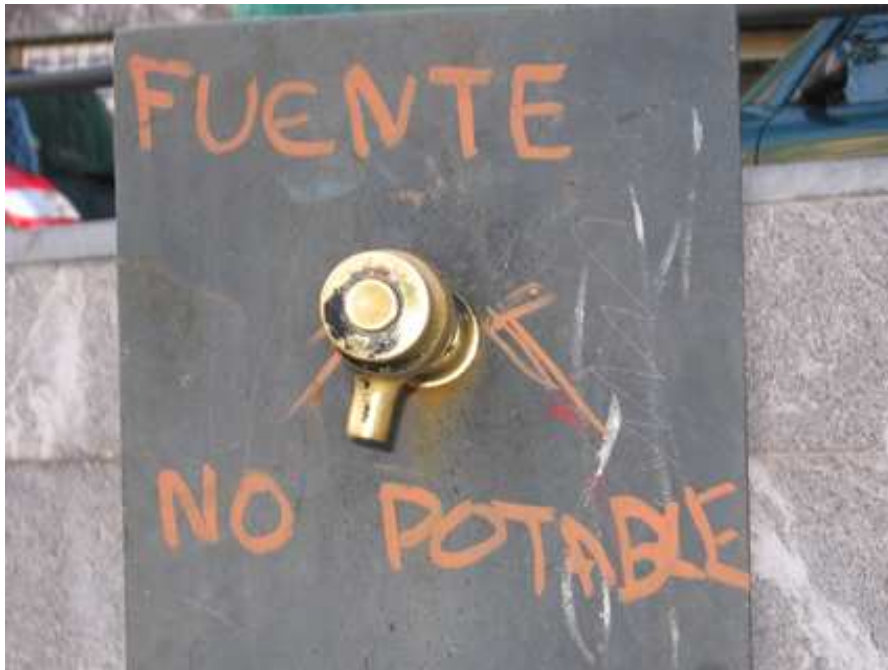
FOTO 3. Fuente 8. Grifo que está torcido y con pintadas.
