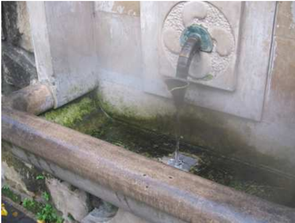
FOTO 2. Fuente 3. Vista de la fuente más cercana, desde la que se pueden apreciar el grifo y el desagüe.
