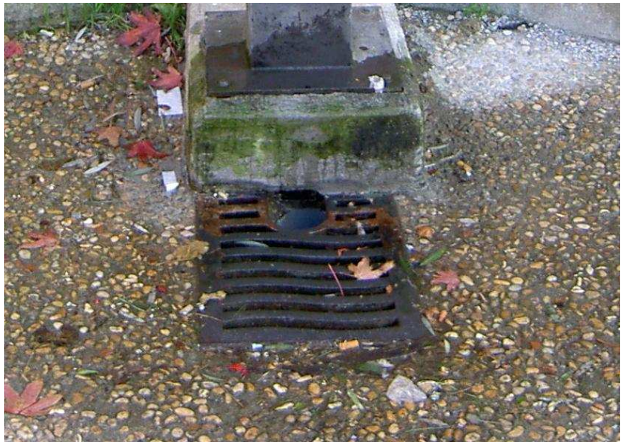
FOTO 3. Fuente 4. Detalle del desagüe.
