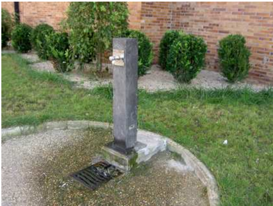
FOTO 1. Fuente 4. Entorno ajardinado en el que está ubicada la fuente.
