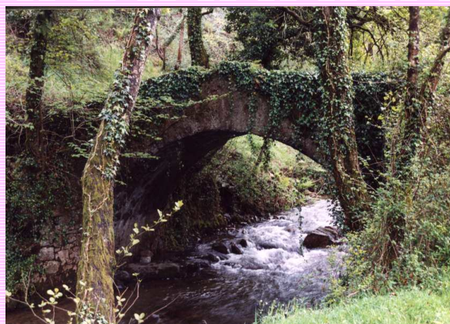
FOTO 24. Puente de la antigua ferrería.
