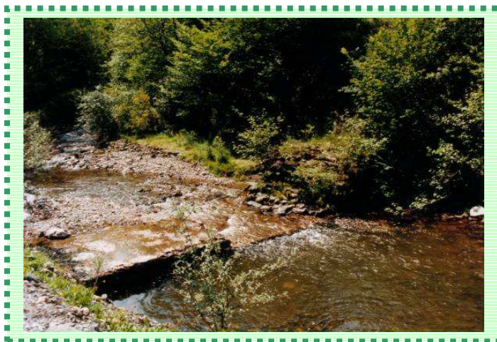
FOTO 7. Restos de la presa existente en la unidad 3.
