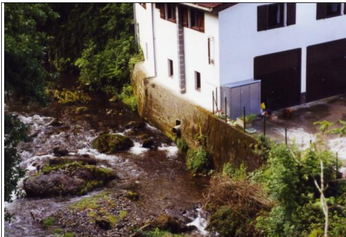
FOTO 3. Vertidos de un caserío al cauce, unidad 6.
