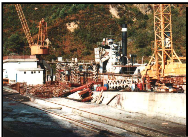
FOTO 12. Astilleros Askorreta, riesgo de contaminación industrial en la unidad 3 .
