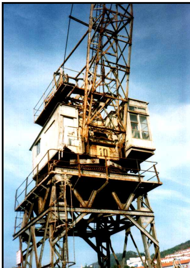
FOTO 17. Grúa antigua del Puerto de Pasaia.
